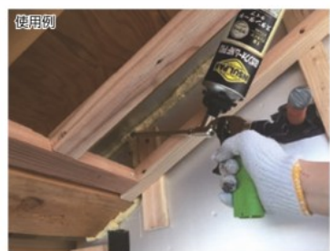
壁と屋根の取り合い部の断熱に
