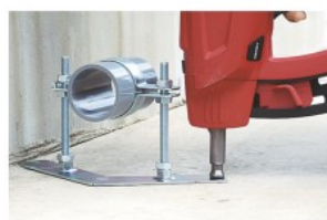
ガス式釘打機作業
