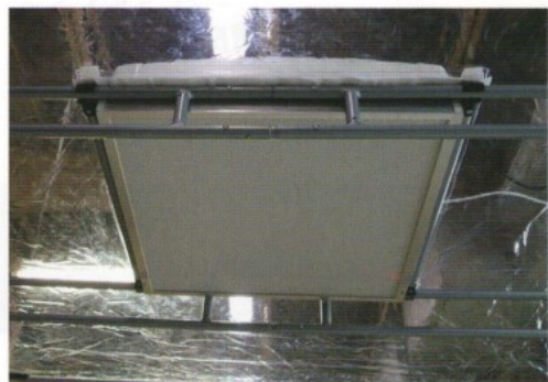
天井フレームにファンフィルターユニットを設置
