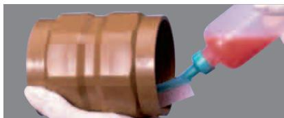
ゴム輪がスムーズに入るように、ゴム輪又はスリーブ(継手受口)に専用の石けん水を塗布して下さい。
