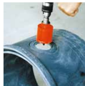
▲プラ排水マス
