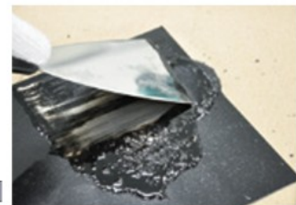
塗装のはく離に
