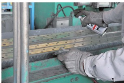
建設用足場の防食補修
